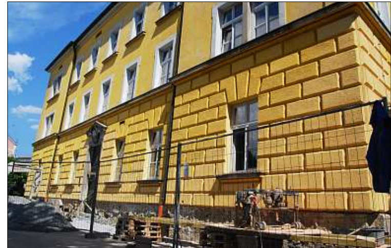
Der komplette Sockelbereich des Amtsgerichts ist derzeit freigelegt – und auf etwa einem Meter Höhe wird das Gebäude rundherum durchgesägt.
