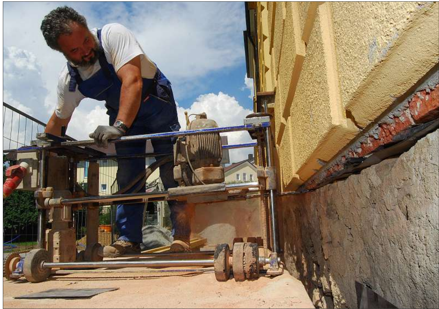
Mit der Säge quer durchs Gemäuer: Ingenieur Ralf Schulenburg sägt eine Spalte frei – hier kommt anschließend eine Kunststoffplatte hinein, die das Aufsteigen von Feuchtigkeit verhindert. – Fotos: Jahns
